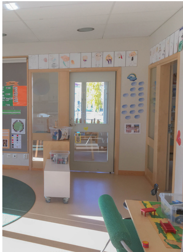
Abbildung 8 — Gruppenraum mit Akustikdecke und Sichtfenster in Wand und Tür (in Umeå)
